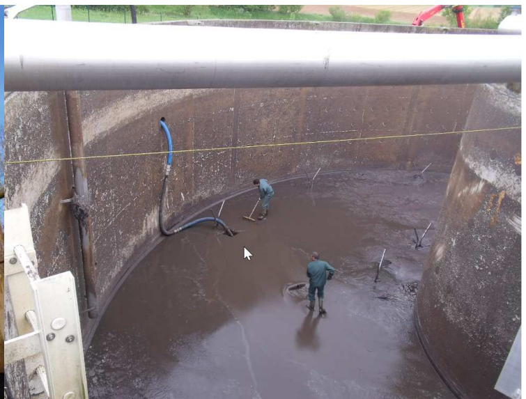
Renouvellement des diffuseurs fines bulles de la STEP de Pelle-Chat
