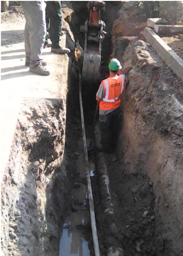
Figure 6 : renouvellement de réseau – la Tranchée (Niort)
