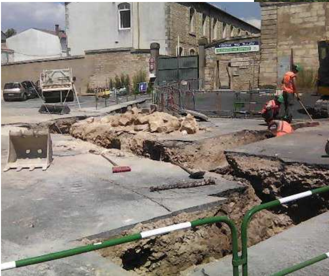
Renouvellement réseau unitaire Place Chanzy Niort)
