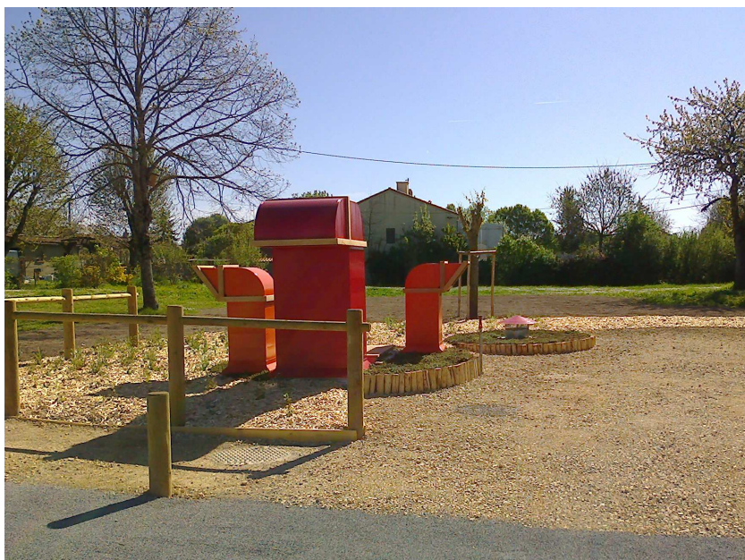
Figure 2 : poste Refoulement Amuré
