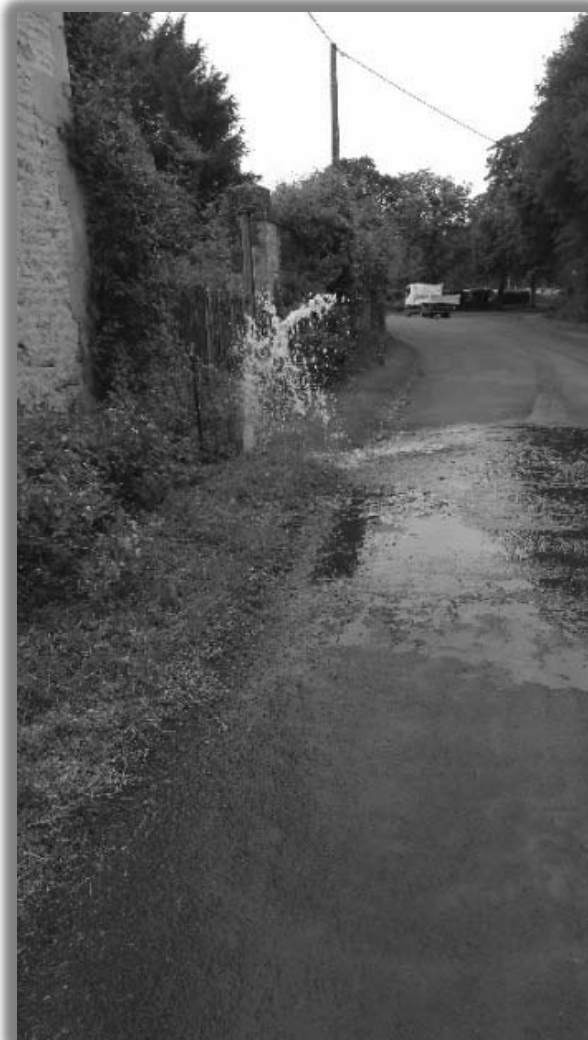
Réalisation d'une purge sur le réseau
