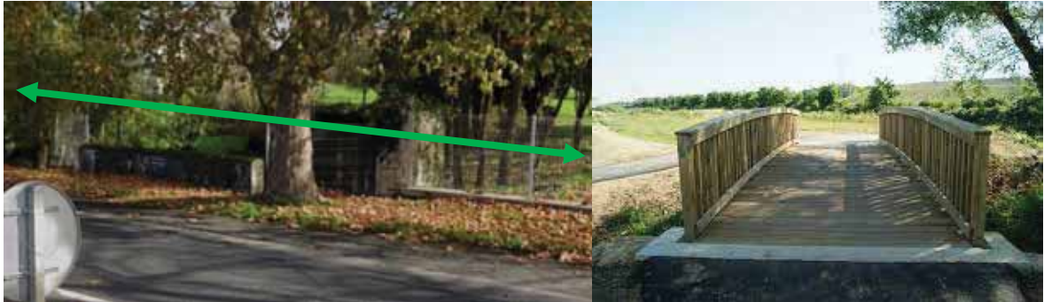
Passage de la voie verte et exemple d'ouvrage type
