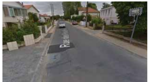
Traversée de Bessines, rue des Petits Prés, en zone 30, avec très peu d'aménagements ; Source : google
