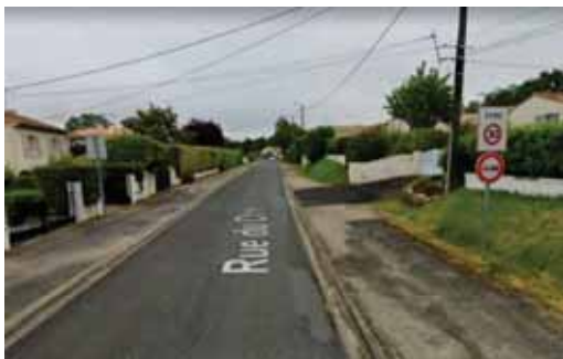
Entrée de Zone 30 de Bessines, rue du Centre, sans aménagement spécifique ; Source : google
