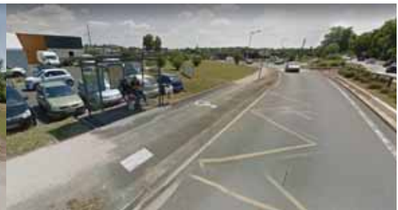
Risque de conflit entre les piétons, les usagers de la piste cyclable obligatoire sur trottoir, l'espace d'attente de bus et l'accès PMR ; Source : google
