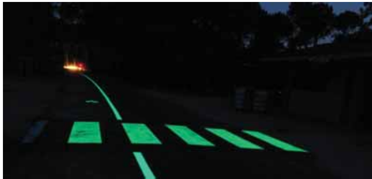
Bande cyclable et passage piéton phosphorescent (source : luminokrom.com)
