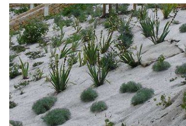
Talus recouvert d'une toile non tissée en fibre végétale
