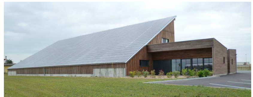
Bâtiment avec toiture recouverte de panneaux photovoltaïques
